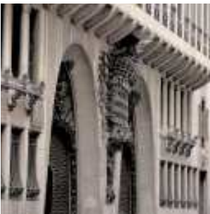
Uno de los primeros arcos de perfil aproximadamente parabólico de grandes dimensiones de la obra de Gaudí, en el Palau Güell (fig. 11)
