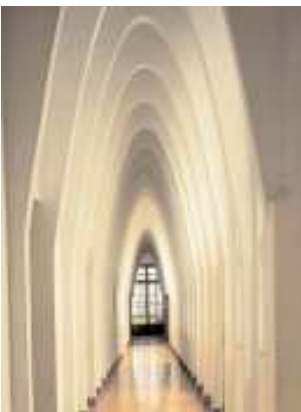
Arcos catenarios de las casas Milà y Batlló y del colegio de las Teresianas
