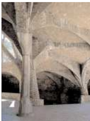
Paraboloides hiperbólicos de los soportales de la iglesia de la Colònia Güell
