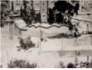
Conoide de la cubierta del obrador de las Escuelas Provisionales de Gaudí
