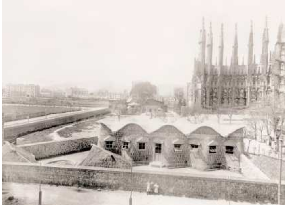
Conoides de la cubierta y los muros de las Escuelas Provisionales de la Sagrada Familia
