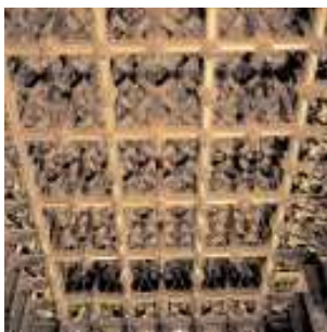
Techo artesonado de aspecto decorativo, pero con comportamiento estructural, del Palau Güell (fig. 13)
