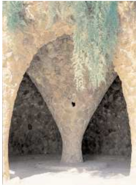
Bóveda hiperbólica para el giro de carruajes de la entrada del Parc Güell (fig. 4)
