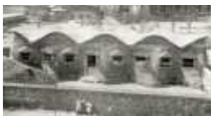
Conoides de los muros perimetrales de las Escuelas Provisionales de la Sagrada Família (fig. 14)
