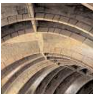
Con el ladrillo formando elementos tabicados pueden hacerse estructuras de apoyo ligeras y resistentes, como en la Casa Milà (fig. 16)
