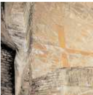
Los arcos que soportan todo el conjunto no tienen forma circular, sino poligonal (fig. 28)
