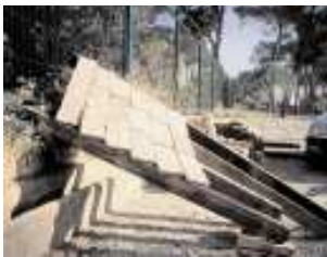
Cuatro tabloneros apoyados en el suelo y en otro tablón inclinado soportan una superficie alabeada (fig. 1)
