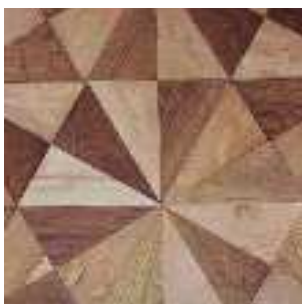
Mosaico de parquet basado en la división del hexágono regular en triángulos rectángulos
