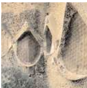
Las formas aparentemente libres que rodean la ventana tienen en realidad la función de desagüe (fig. 26)
