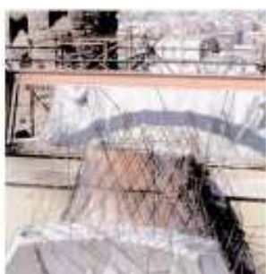
Detalle de la construcción de un hiperboloide de una hoja donde se observa el armado siguiendo sus generatrices (fig. 1)
