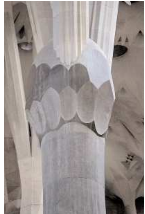
Maclación de planos y elipsoides del nudo de la columna basáltica del templo de la Sagrada Família
