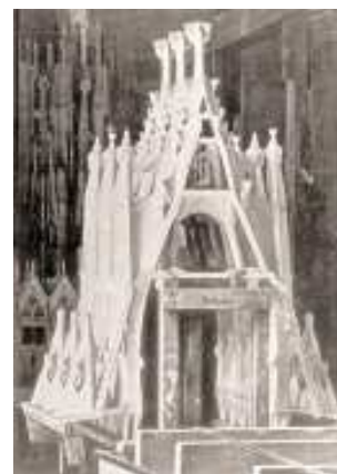
Cálculo funicular de la nave del templo de la Sagrada Família, publicado en 1923 en el Anuario de Arquitectos , y maqueta de la cubierta correspondiente a la parte superior del esquema de cálculo gráfico
