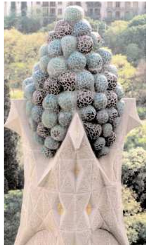
C. A. Maclación de paraboloides hiperbólicos de un pináculo de la fachada de la nave del templo de la Sagrada Família
