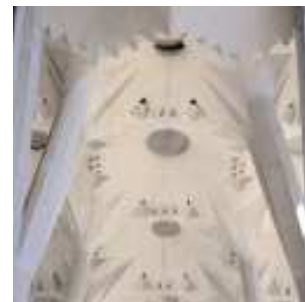
Detalle de un hiperboloide de una hoja de la nave central del templo de la Sagrada Família (fig. 6)
