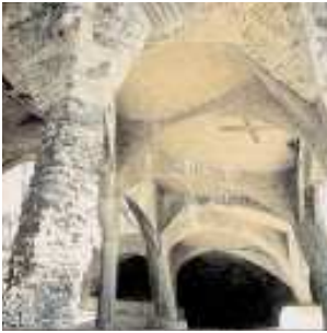
Soportal de la iglesia de la Colònia Güell. Si el lector gira 180 grados el libro verá que los arcos tienen la misma forma que los hilos de la maqueta invertida (fig. 27)
