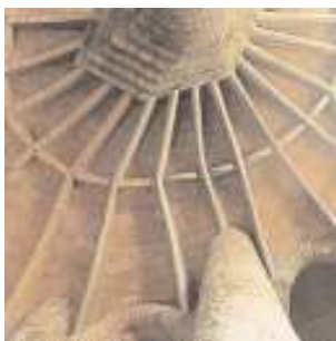
Pruebas de formas diversas, hechas con mortero de cemento pórtland, para dar un acabado más rico a los arcos del techo de la iglesia de la Colònia Güell (fig. 23)
