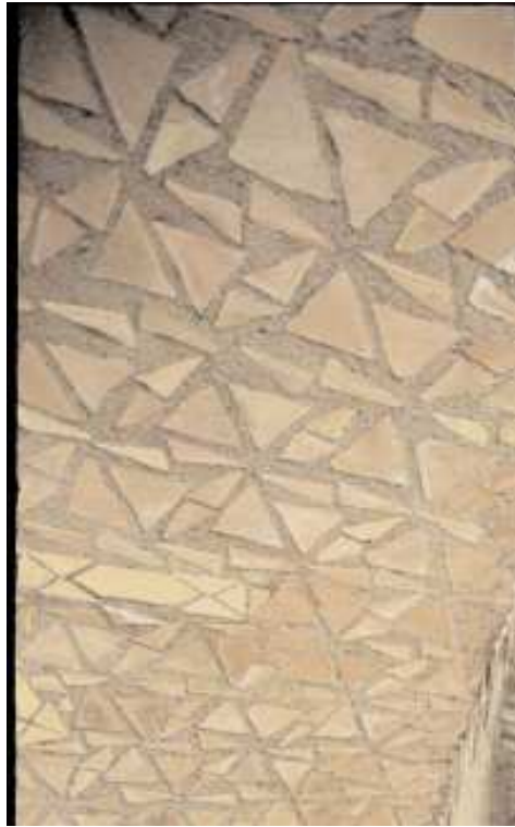
Los dos tramos de forma circular no se encuentran en la clave (fig. 29)
