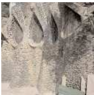
Los aparentes contrafuertes son en realidad ondulaciones del muro que le dan rigidez (fig. 25)
