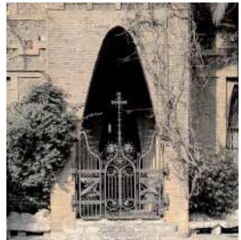
Arcos parabólicos de la entrada del colegio de las Teresianas (fig. 2)
