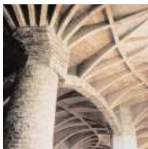
Detalle del techo de la iglesia de la Colònia Güell. Si el lector gira el libro 180 grados podrá ver que los arcos parecen realmente hilos colgados (fig. 22)
